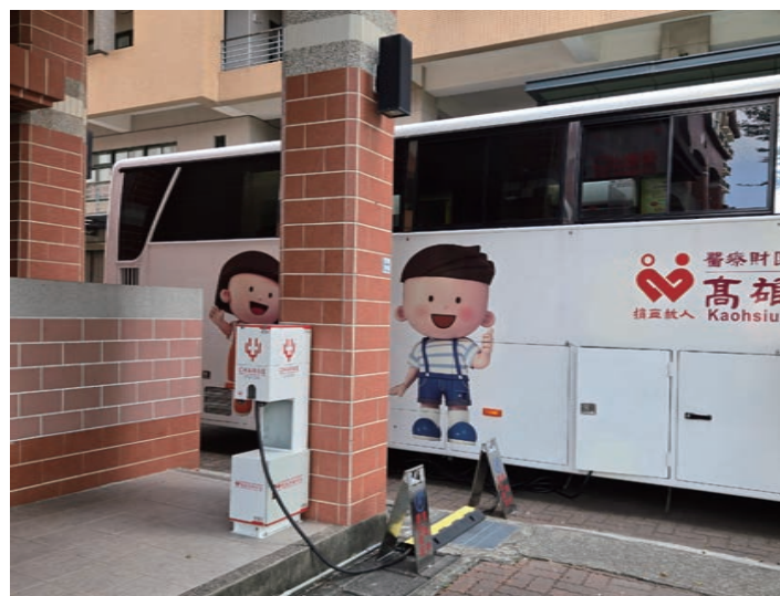
▲ 在經常辦理捐血活動的場所設置插電箱，讓油電混合捐血車到點隨插即用。圖為設置於中華醫事科技大學的插電樁。
